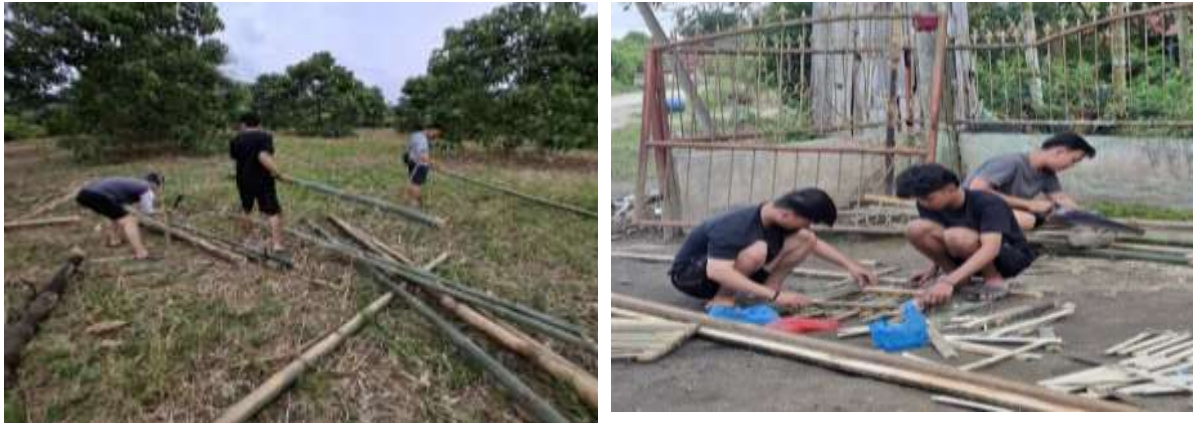
Gambar 3. Pengerjaan tempat sampah
